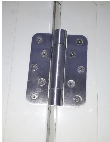
Abbildung 7: Vernieten der Türscharniere.
